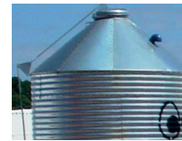
Respiro en el techo Roof vent
